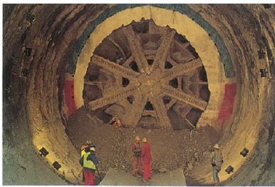
英国シェークスピアから掘り進んだTBMのホリウエル立て坑への到達
