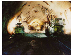
第1段ベンチ掘削 1st bench
